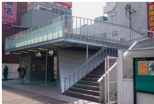
(OMテラス 全景)
