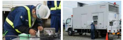
応急復旧光ケーブル接続
