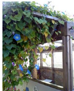
屋上緑化の取り組み
