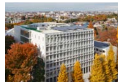
NTT中央研修センター5号館
