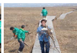
植物の撤去作業風景
