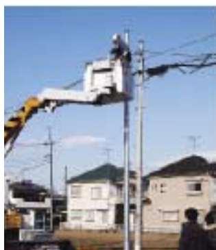
エコ鋼管柱を建てているところ
